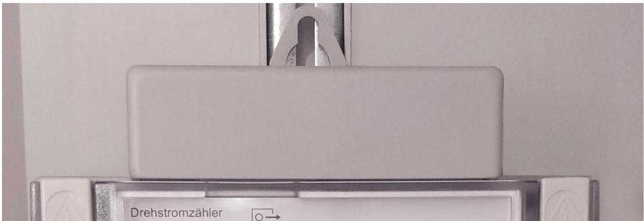
Bei Bedarf kann das Modul an der Trägerschiene für den Zähler angeschraubt werden, sodass ein einfaches Abnehmen des Moduls nicht mehr möglich ist.
